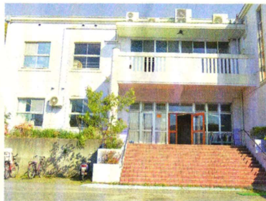
平成元年開設の湘南セシリア。 正面に階段がある
