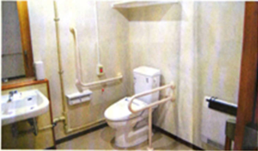
多目的トイレ
